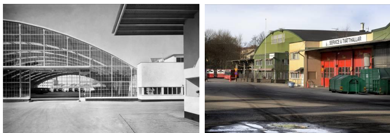
Ursprunglig och befintlig bussdepå (foton: Spårvägmuseet och Tomasz Pydzik)
